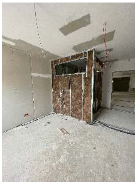
Bad im Bewohnerzimmer – Verkabelung, Dämmung, Trockenbau mit Fensterausschnitt.
