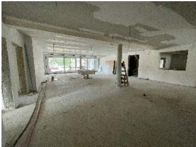
Großzügiger und heller Aufenthaltsbereich.
