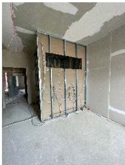
Bad im Bewohnerzimmer – Verkabelung, Dämmung, Trockenbau mit Fensterausschnitt.
