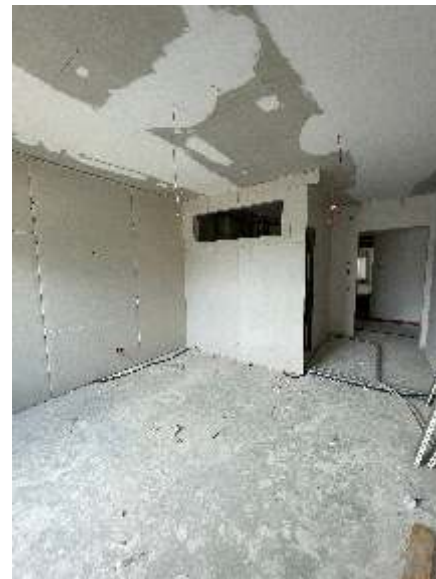
Bad im Bewohnerzimmer – Verkabelung, Dämmung, Trockenbau mit Fensterausschnitt.
