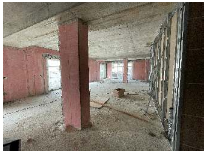
Blick aus dem Empfangsbereich in das Café in Richtung Terrasse
